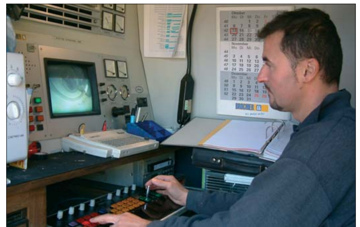
Foto: Aus dem Fahrzeug kann der Zustand des Kanales mit einer Kamera überprüft werden
