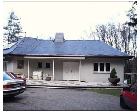
Abb. 2: Nach der Dachsanierung: neue Schiefer-eindeckung und seitliche Integration der Sonnenkollektoren (mit Ausrichtung nach Süden):
