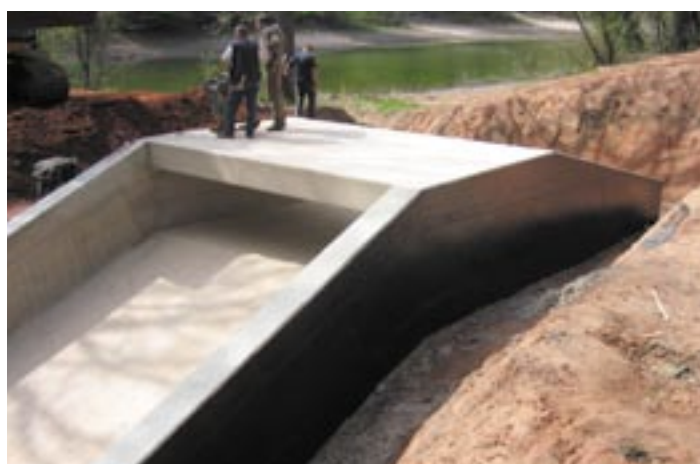
So sah die fertige Dammschicht vor der abschließenden Geländemodellierung aus.
