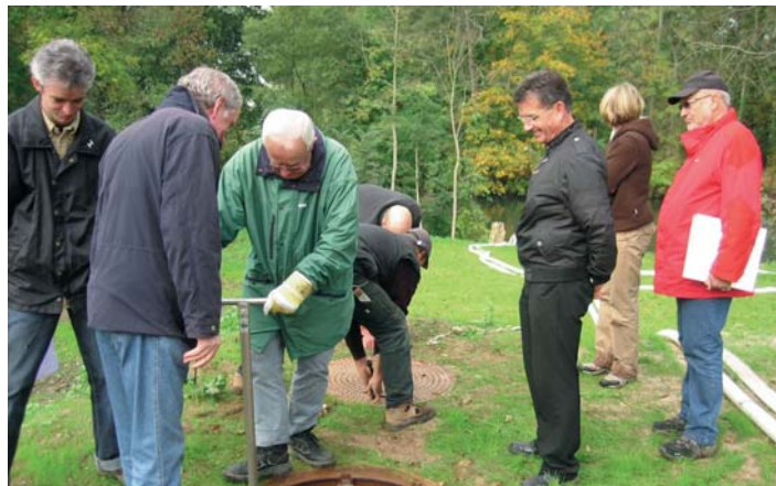
Herr Sitta vom Landesamt für Umweltschutz und Herr Seimetz vom Entsorgungsverband Saar bei der Abnahme des 1. Bauabschnittes.
