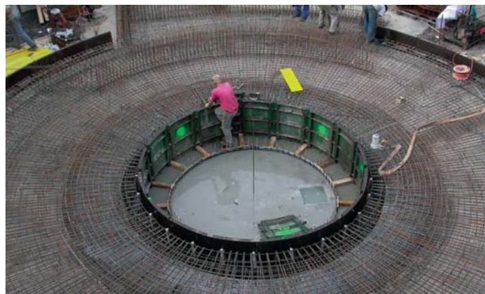
Das große Kompaktbecken bietet auch bei starken Regenfällen genügend Speicher.
