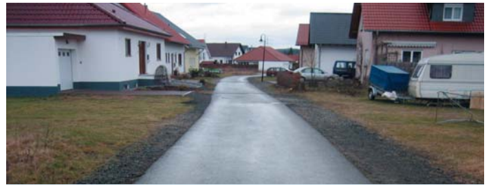
Die Straße „Auf dem Felsen“ wird im Endausbau gepflastert sein.
