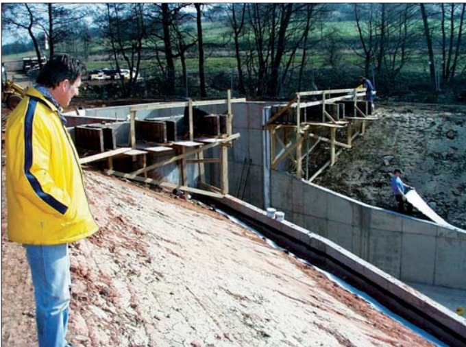
Es geht voran: Herr Reeb von der Fa. Peter Gross KG ist der „Gelbe Engel“ der Baustellen Teichkläranlage und Hauptsammler Wittersheim
