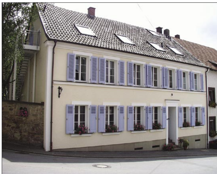
Wohnhaus nach Renovierung in Heckendalheim
