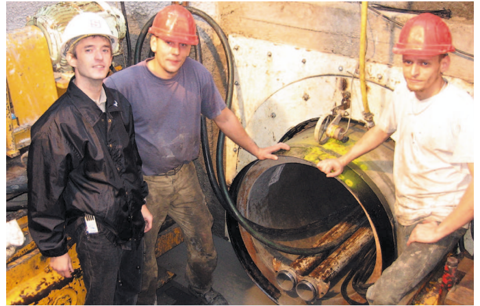
Der Kanal wird ohne offenen Baugraben auf 70 Metern durchs Erdreich gepresst.
