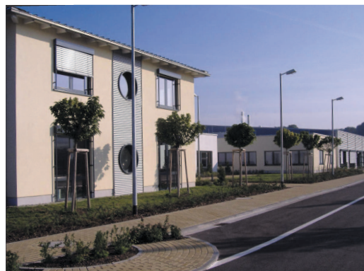
Funktionalität geht einher mit einer ansprechenden Architektur.
