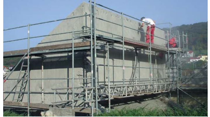
Die aufwändige Betonsanierung sichert die Einsegnungshalle für die nächsten Jahre.
