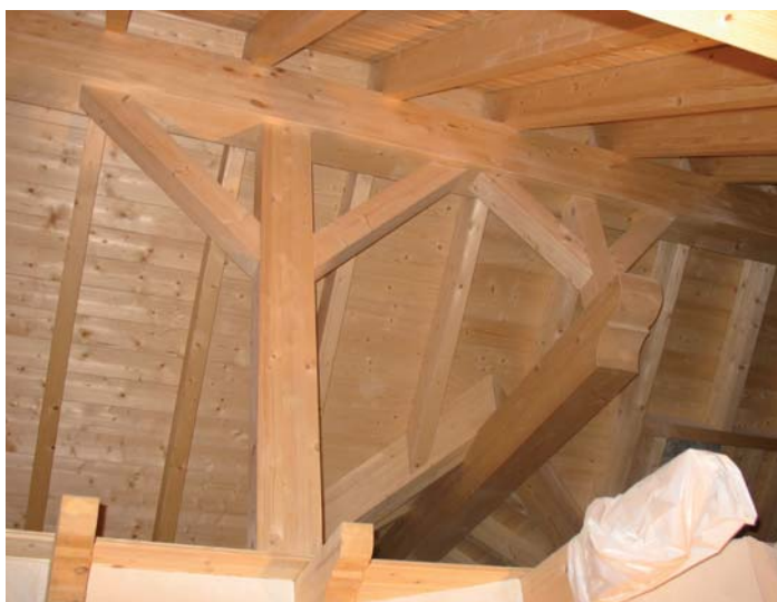
Im Dachfirst entsteht ein ganz gemütlicher Ruheort.
