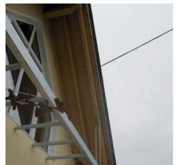
Die professionelle Zimmermannsarbeit ist bereits von außen am Dachstuhl zu erkennen.
