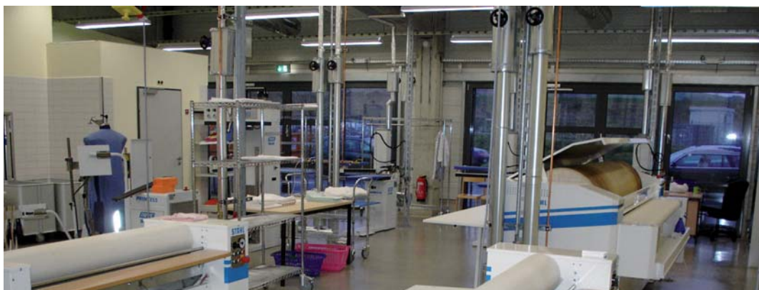
Die Planungen für die Wäscherei der Lebenshilfe in Blieskastel waren für den Architekturpreis nominiert.
