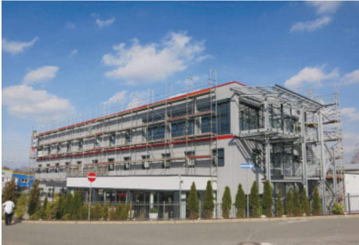
Die Erweiterung des Grunder-Gebäudes erfolgte im laufenden Betrieb.
