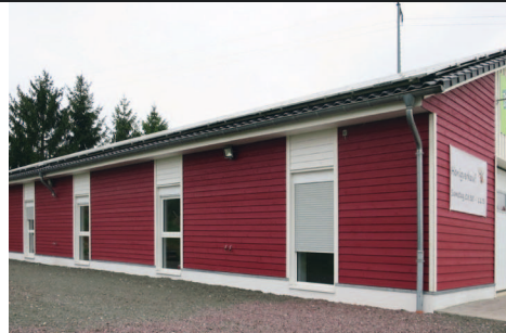
Neubau Produktionshalle Biohonig Wenzel Seelbach
