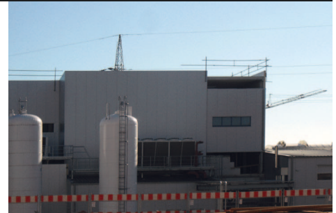
KD Pharma Baumaßnahme, Bexbach
