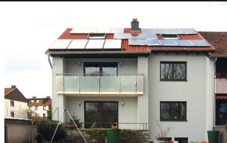
Komplette energetische Sanierung
