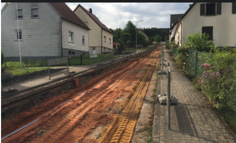
Kanal- und Straßensanierung „Von-der-Leyen-Straße“, Bliesdalheim
